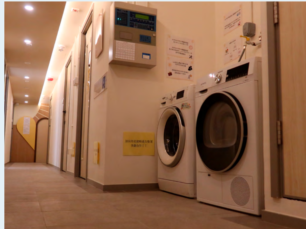
“匠心园”红磡过渡性房屋项目
